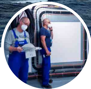
PLANUNG. Auch unter Pandemiebedingungen konnte das Projekt vorangetrieben werden.
