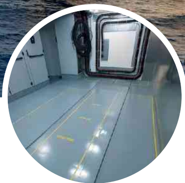
VORBEREITUNG. Bereits in der Bauphase wurde genug Platz für die erforderlichen Systeme vorgesehen.
